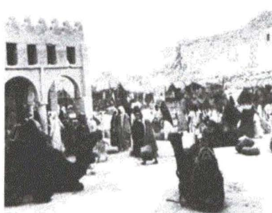
سوق الهفوف الرئيسي ويبدو في الصورة سور الكوت
