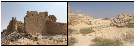
صورة (15): التفكك الكتلي في جدران قلعة الوجاج صورة (16): التفكك الكتلي في جدران قلعة بنت قنيص
