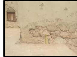
صورة (18): تلف وتساقط طبقات الملاط من جدران مسجد جواثا بفعل الرطوبة الأرضية. المصدر: تصوير الباحثان، الدراسة الميدانية، سبتمبر 2019م، ناظرًا باتجاه الشرق
