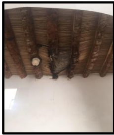
صورة (21): تأثير المياه على أحد الأسقف لأحد النوافذ الخشبية بالمدرسة الأميرية الخشبية بمسجد الجبري
