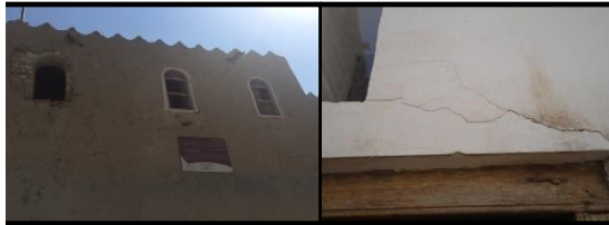
صورة (13): التشريحات الدقيقة في طبقات الملاط ببيت البيعة صورة (14): تشريح وانفصال طبقة الملاط على أحد الواجهات في قصر إبراهيم
