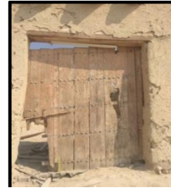
صورة (17): تشرح الخشب وانفصال أجزائه نتيجة التغير في أبعاده الناتجة عن فقده محتواه المائي بفعل التعرض للحرارة العالية بقصر الوزية.
