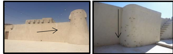
صورة (22): الثقوب والحفر في الجدران الخارجية بقصر محيرس. صورة (23): الثقوب والحفر في الجدران الخارجية بمسجد جواثا. المصدر: تصوير الباحثان، الدراسة الميدانية، سبتمبر 2019م، ناظرًا باتجاه الجنوب، الغرب
