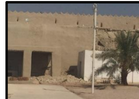
صورة (19): تحطم أحد الجدران الداخلية لقصر إبراهيم بفعل تسرب المطر
