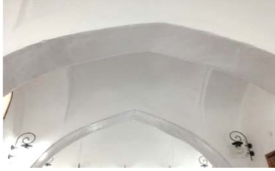
الشكل 11: تظهر القبة المستطيلة وسقف المسجد وقاعدته على عقدتين عموديين على جدار القبلة ، وقوسان صغيران موازيان لجدار القبلة. (المصدر: من عمل الباحث).
