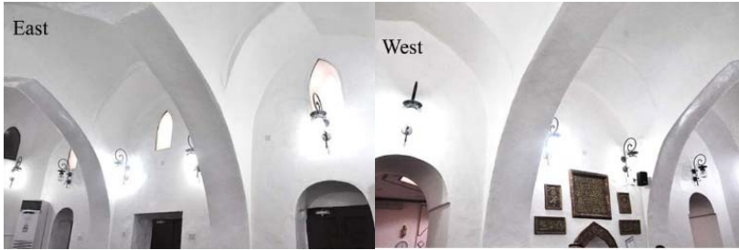
الشكل 10: الأقواس الشمالية والجنوبية متعامدة مع جدار القبلة. هم انهم مبني على جدار القبلة والجدار الشرقي المقابل له. كما تظهر سقف المسجد مع وجود عوارض عمودية أصغر عليه. ((المصدر: من عمل الباحث)).
