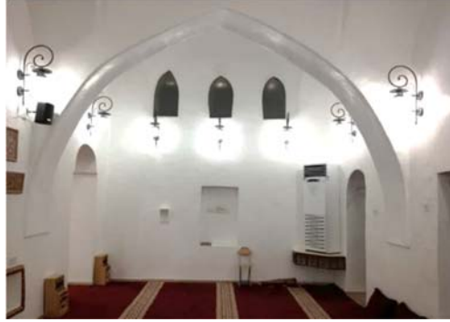
شكل 9: العقد الرأسي الشمالي على جدار القبلة مبني على جدار القبلة و الجدار الشمالي المقابل له ، وتحتله النوافذ المغلقة التي تشكل الجدار الشمالي. ((المصدر: من عمل الباحث)).
